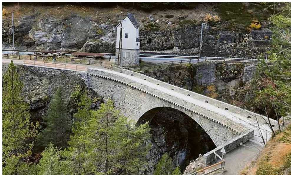
Die verbreiterte Jenisbergbrücke bei der Station Wiesen.
