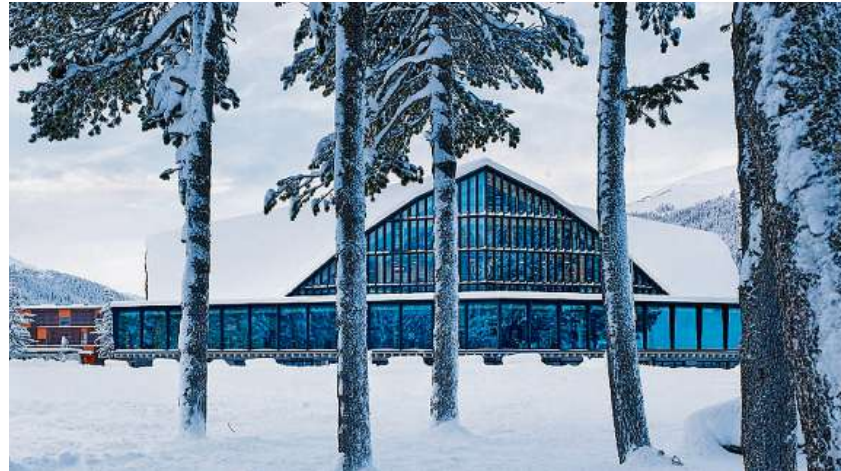
Mit einer Auszeichnung bedacht: die Erweiterung des Davoser Eisstadions von Marques Architekten AG für die Gemeinde Davos.
