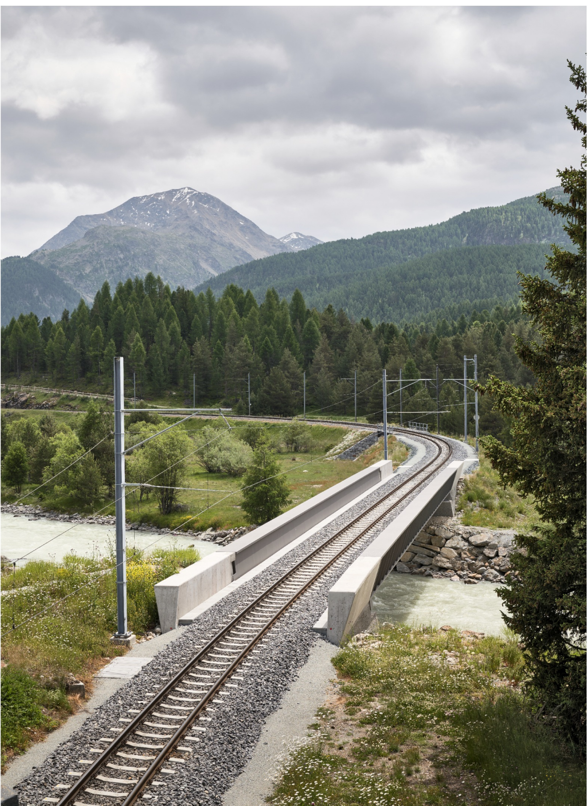
FLAZBACHBRÜCKE PUNT MURAGL
