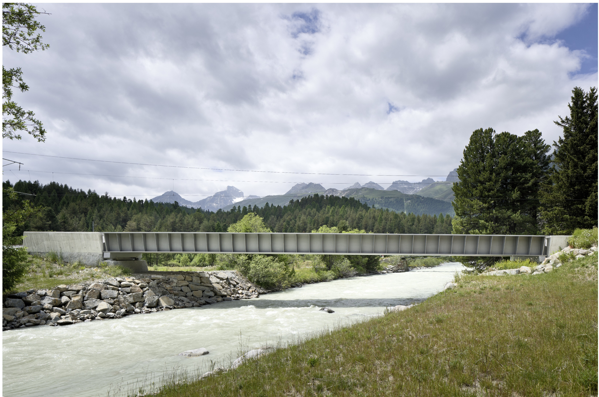
FLAZBACHBRÜCKE PUNT MURAGL
