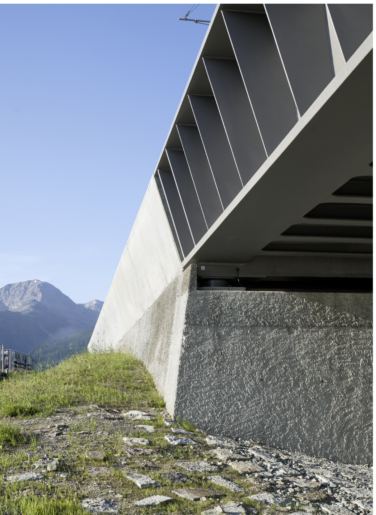
DETAIL WIDERLAGER BINNENKANALBRÜCKE
