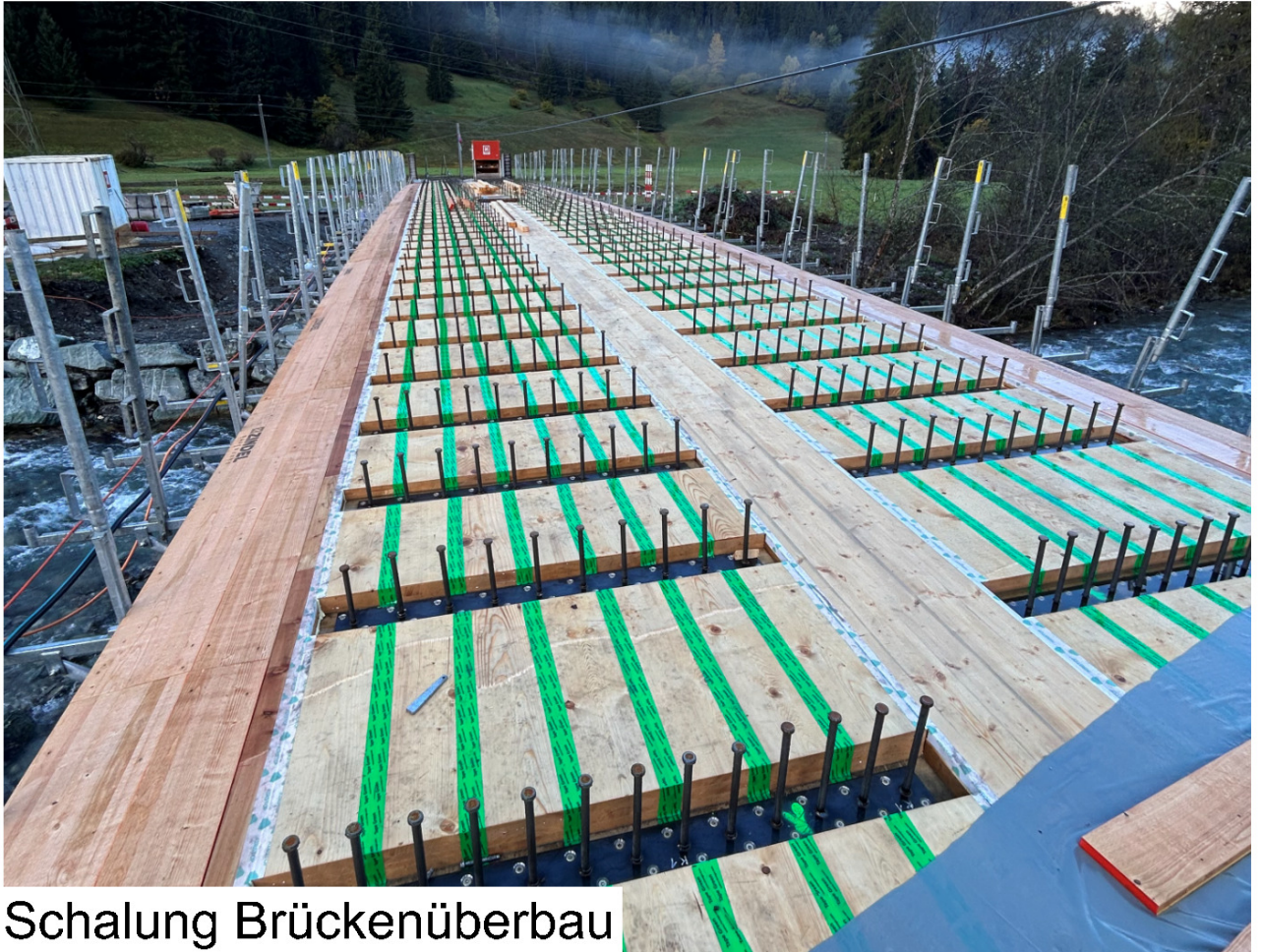
Schalung Brückenüberbau
