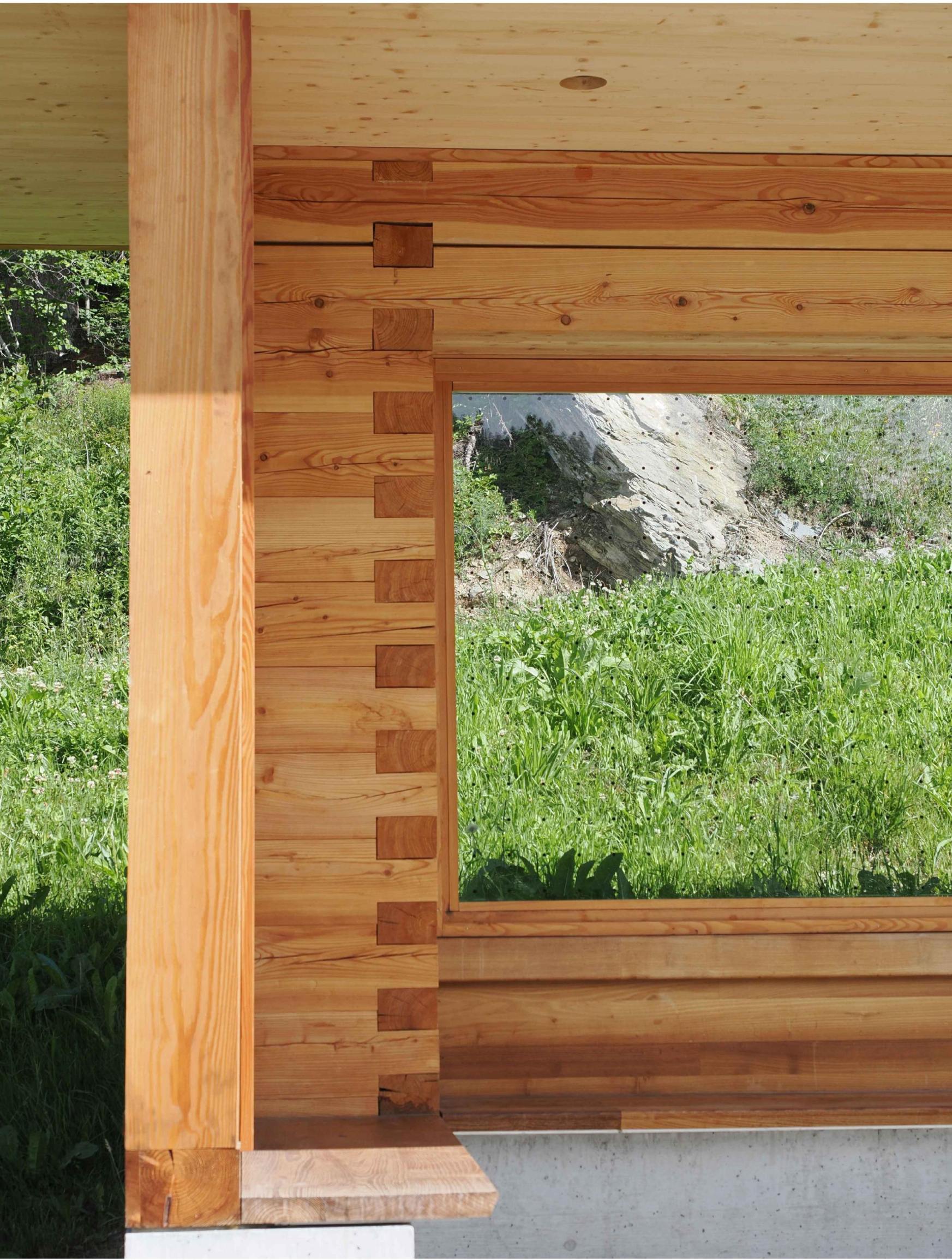
Lärchenholzstrick mit Fingerzinkenverbindung
