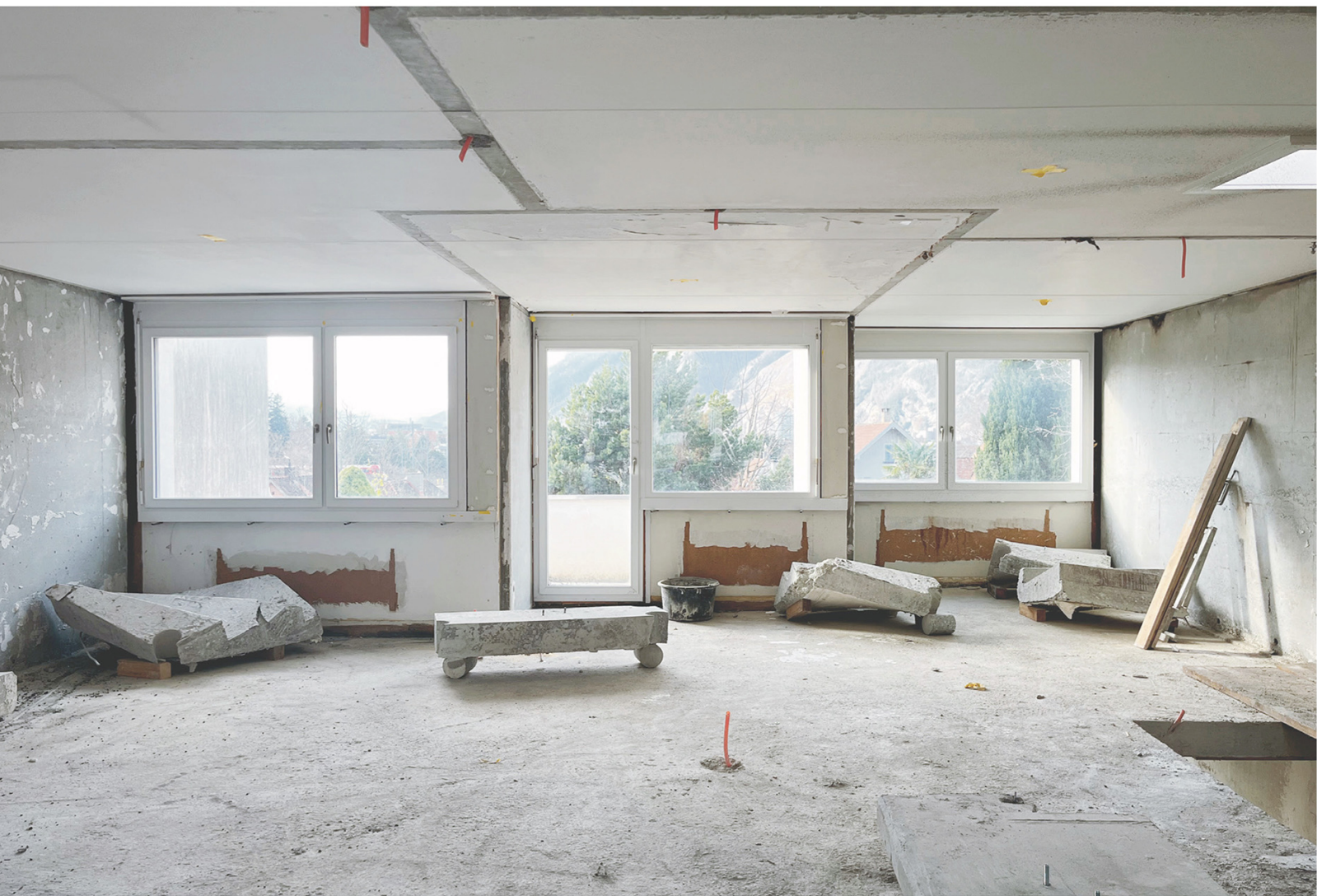
Deckenplatte von Schotte zu Schotte 8.50 Meter
