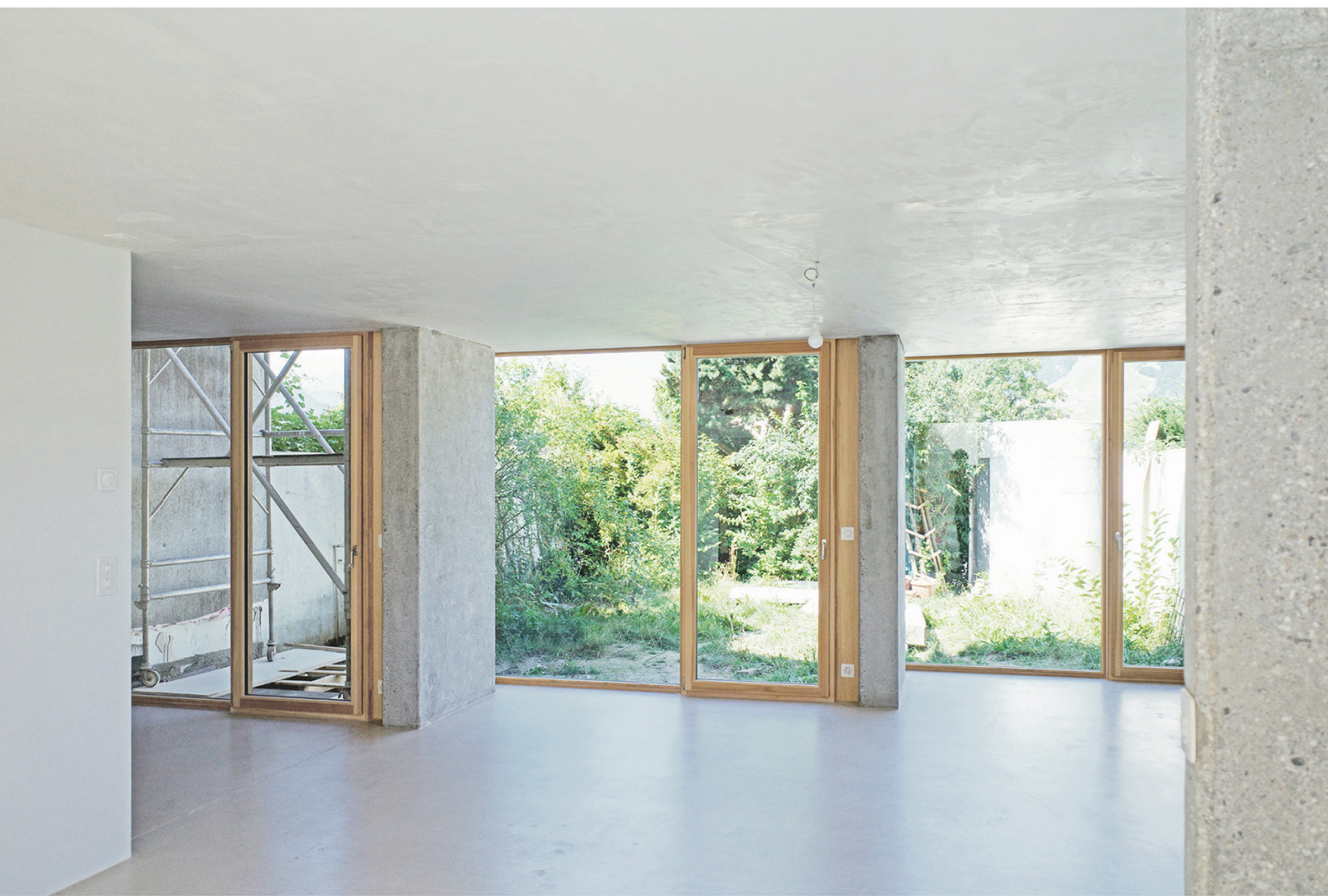
Ergeschoss mit freigelegten Betonscheiben
