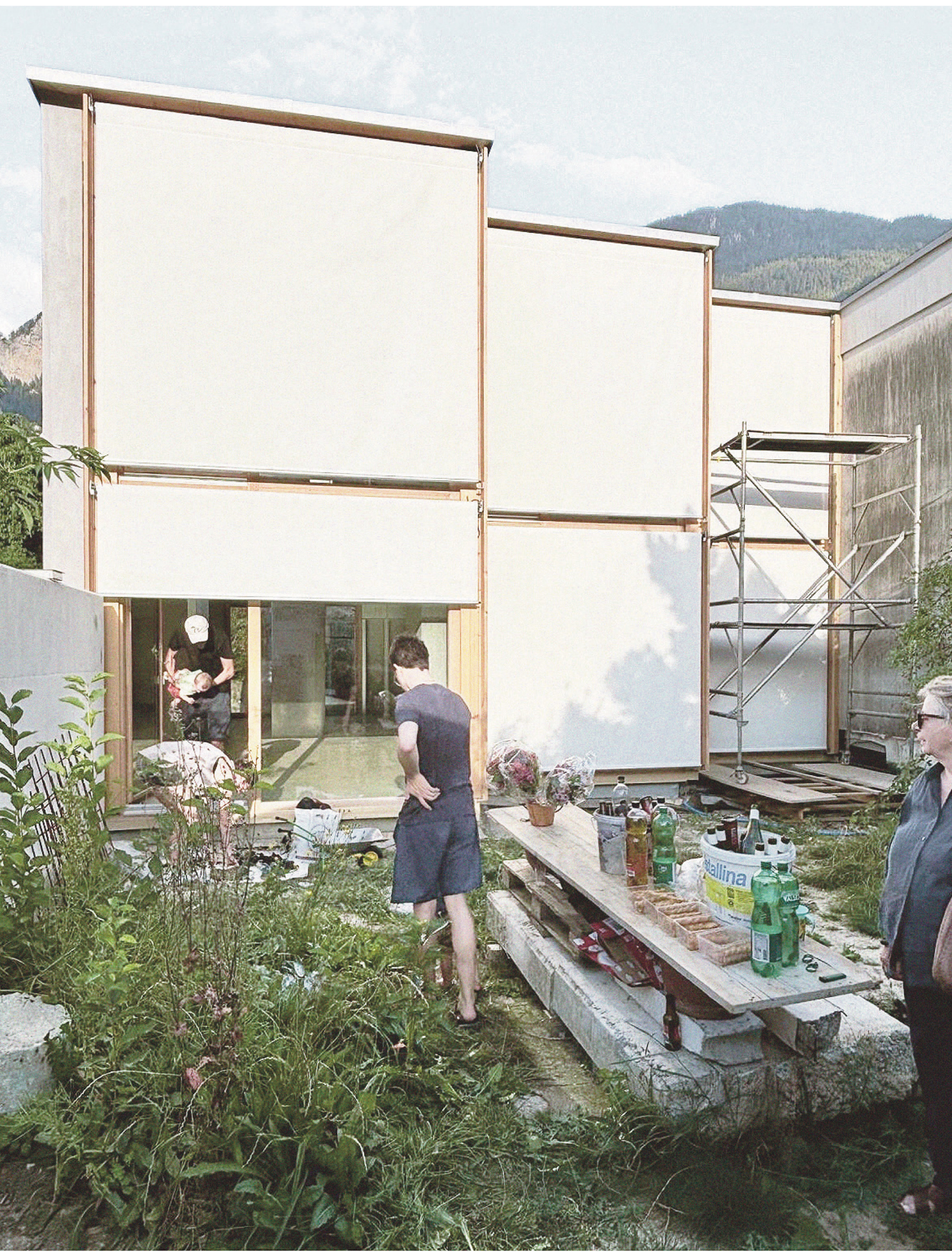
Fassade Garten mit Sonnenschutz
