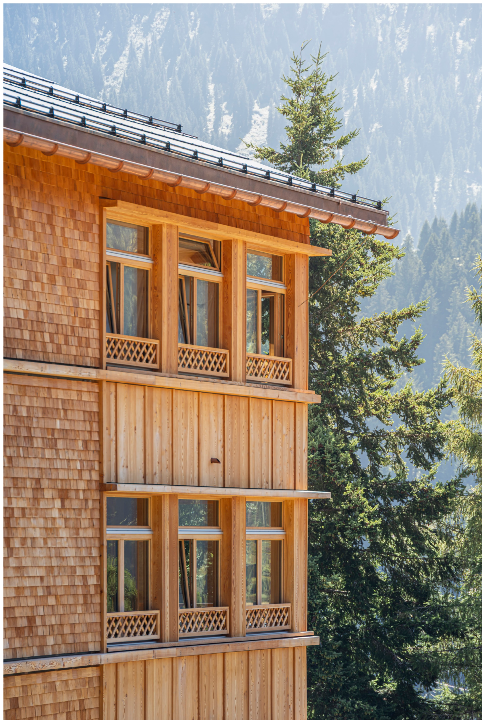
Fassadengestaltung beim Wintergarten
